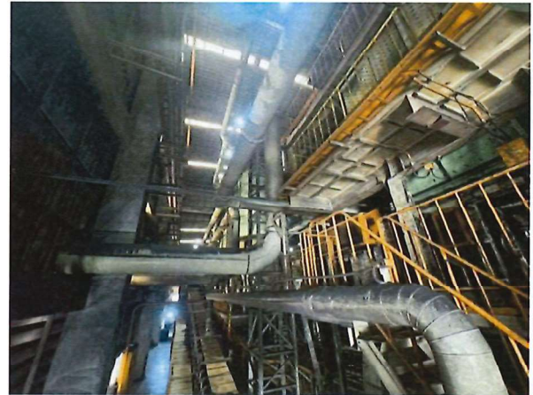
ภาพที่ 8 ระบบดูดอากาศในพื้นที่การผลิตที่เกี่ยวข้องกับ ทราย
