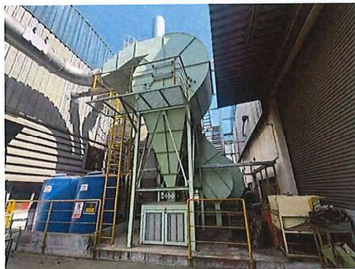
ภาพที่ 52 ระบบ Wet Scrubber
