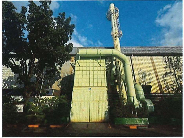
ภาพที่ 4 ปล่องระบบดักฝุ่นจากขั้นตอน Finishing & Grinding (BH4)
