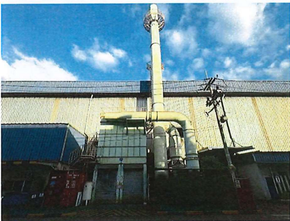
ภาพที่ 5 ปล่องระบบดักฝุ่นจากขั้นตอน Pouring line (BH5)
