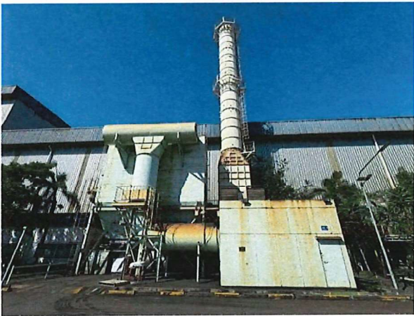
ภาพที่ 3 ปล่องระบบดักฝุ่นจากขั้นตอน Molding line (BH3)
