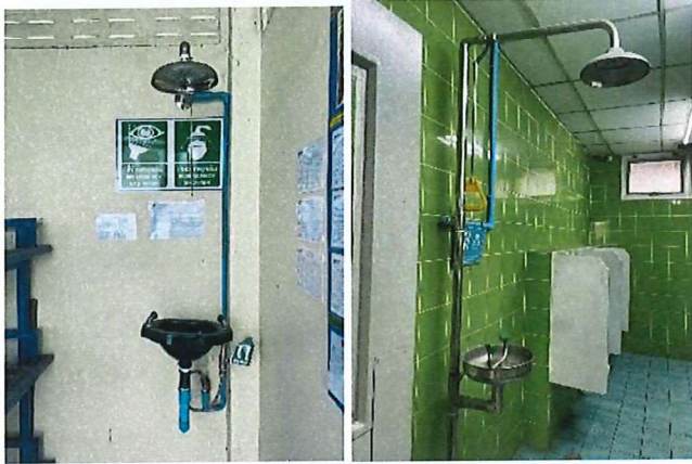
ภาพที่ 37 ฝักบัวและอ่างล้างตาฉุกเฉิน
