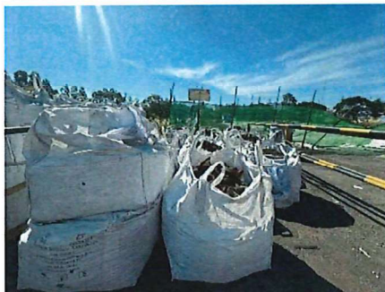
ภาพที่ 60 พื้นที่จัดวางถุงฝุ่นทรายดำ ทรายหล่อแบบ เศษทรายไล่แบบ (ชั่วคราว) พร้อมป้ายชี้บ่ง
